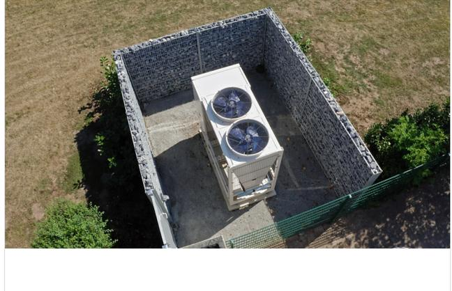
**5** Sobald an den Gebäuden weitere Sanierungsmaßnahmen umgesetzt werden, kann die Luft-Wasser Wärmepumpe AEROTOP® L65 von ELCO die Wärmeerzeugung der Mehrparteienwohnhäuser alleine übernehmen. Foto: ELCO
