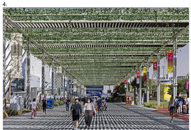
5 Die größte Verschattungsfläche für die EXPO in Dubai mit 56.000 Quadratmetern besteht aus einem Baldachin aus einer nicht-vorgespannten Glasfasermembran. Das Hightech-Textil wurde eigens für das Projekt entwickelt und dient tagsüber der Verschattung, nachts als Reflexionsfläche. Foto: Andreas Keller, Altdorf/Deutschland
