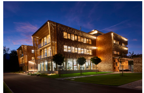
Der Neubau von BORA in Niederndorf (A) wurde nachhaltig geplant und integriert traditionelle und moderne Architekturelemente. Ein besonderes Raumgefühl vermittelt die stimmige Licht- und Akustiklösung von Nimbus.
