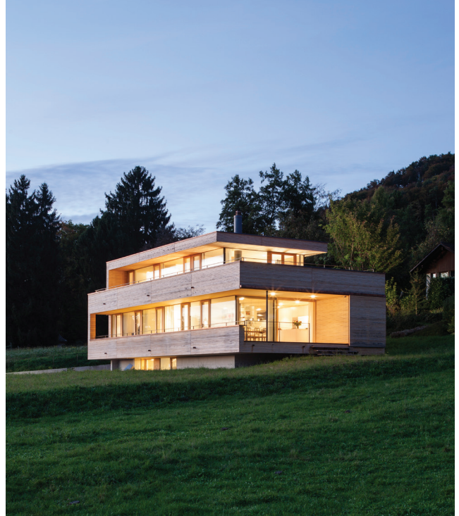
Das vom Architekturbüro k_m architektur aus Bregenz (Österreich) gebaute dreigeschossige Wohnhaus im schweizerischen Ottenberg ist mit Nimbus Leuchten ausgestattet. Foto: Boerje Müller Photography
