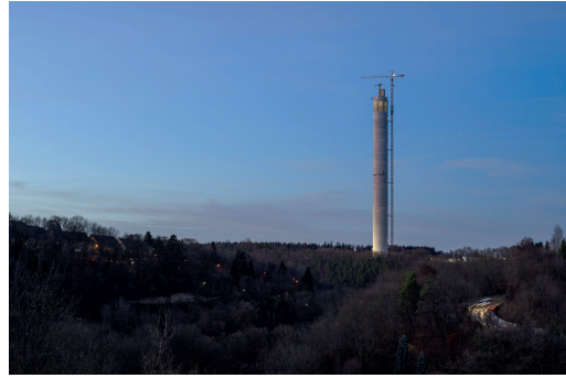
Der Testturm von thyssenkrupp elevators in Rottweil während der aufwendigen Membranmontage. Die von Werner Sobek entwickelte Fassadenkonstruktion aus einem filigranen Glasfasergewebe gilt derzeit als höchstes Membranprojekt weltweit. Foto: Zoëy Braun, Stuttgart
