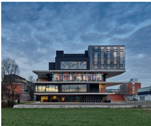
Die Experimentaleinheit Urban Mining & Recycling (UMAR) ist Teil des Forschungsgebäudes NEST auf dem Campus der Eidgenössischen Materialprüfungs- und Forschungsanstalt (Empa) in der Schweiz. Entworfen wurde das sortenrein aus wiederverwendbaren, wiederverwertbaren oder kompostierbaren Materialien konstruierte Wohnmodul von Werner Sobek mit den Projektpartnern Dirk E. Hebel und Felix Heisel. Foto: Zoëy Braun, Stuttgart
