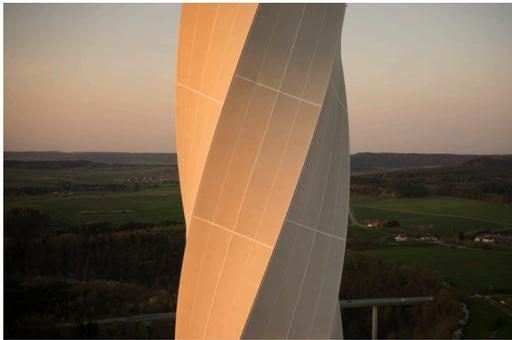
Eine textile Fassade hüllt den Turm auf einer Fläche von 17.000 Quadratmetern ein. Sie hat, wie es für die Entwürfe von Werner Sobek charakteristisch ist, eine hohe ästhetische Qualität. Ihre Konstruktion schützt den Turm vor intensiver Sonneneinstrahlung und trägt zu einer deutlichen Reduzierung der Schwingungen bei, die ansonsten durch den Wind erzeugt würden.
